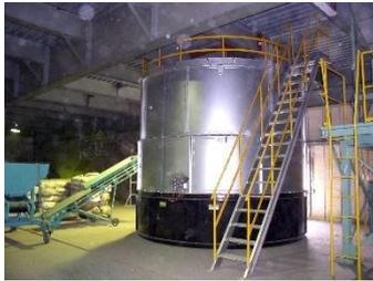
動植物性残さ（生ごみ）、汚泥（有機性汚泥に限る。）及び木くず（伐採樹木等）を処理する施設。加圧混練機とは、異なる工程において、2種類の廃棄物を高速発酵させる。発酵後の堆肥は、人工軽量土壌の資材としてリサイクルしている。
